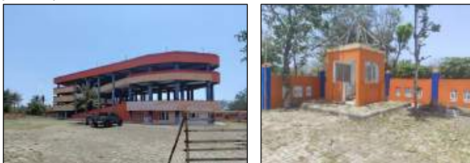
Gambar 3. 12 Pengecatan Tempat Evakuasi Sementara (TES) Tsunami Poncosari
