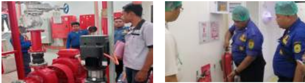
Gambar 3.38 Pendataan Sarana Prasarana Proteksi Kebakaran
